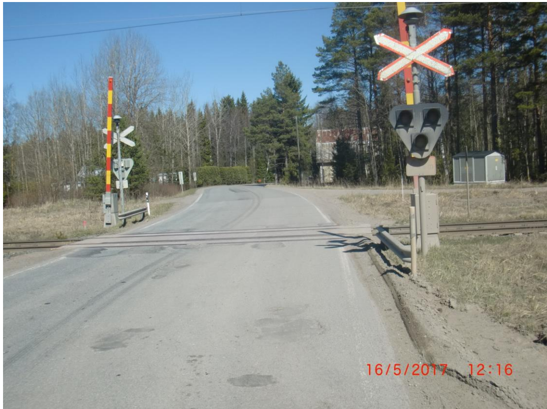
Kuva 14. Vuojoen tasoristeys (tasoristeyksen raportti, Destia Rail Oy 2017). Näkymä etelästä.
