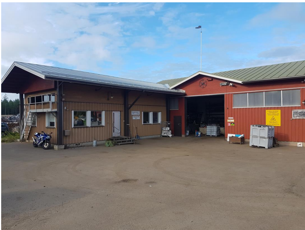
Kuva 9. Hankealueella sijaitseva Eurajoen Romun toimistorakennus.
