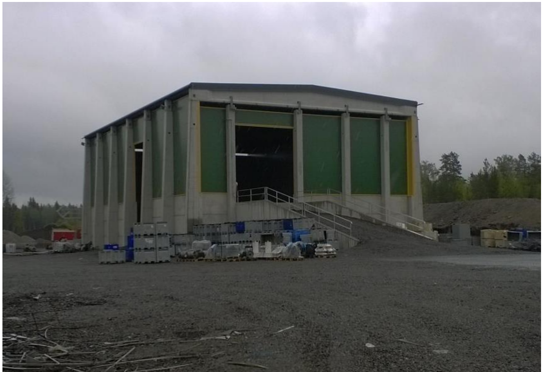
Kuva 5. Uusi akkuterminaali. Akkuterminaalin alueen pinnoitustyöt ovat vielä kuvassa kesken.
